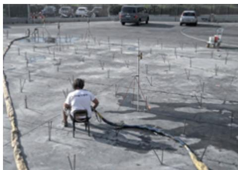
Uretek permette d'incrementare le prestazioni delle pavimentazioni di carico, dei piazzali di stoccaggio o delle banchine attraverso interventi circoscritti, nel corso della regolare attività quotidiana, ottenendo benefici e risultati immediatamente verificabili con la possibilità di eseguire collaudi appena terminato l'intervento del personale specializzato.
